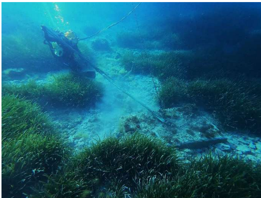
Figura 7: buzo atando un bloque de hormigón para poder ser extraído desde la grúa de la embarcación.
